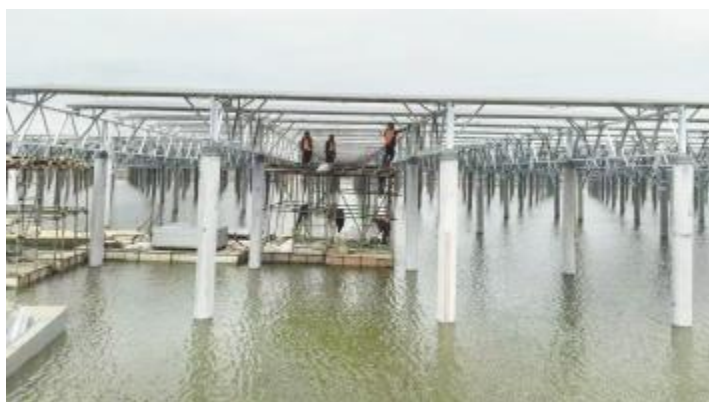
通威天门“渔光一体”二期增容项目安全有序复工
