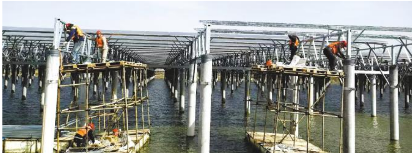
通威天门“渔光一体”二期增容项目建设现场
