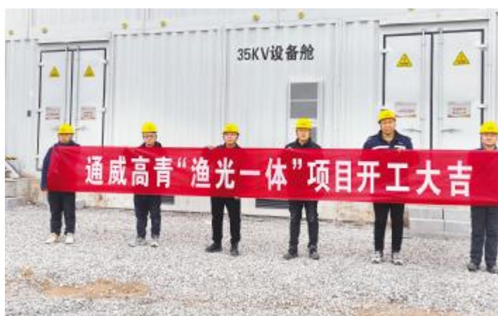
通威高青“渔(农)光一体”项目开工现场
