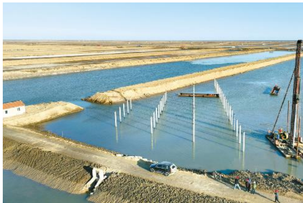
通威东营“渔光一体”生态园二期项目抢抓建设
