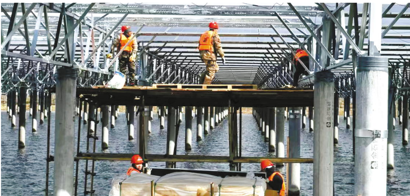
通威天门“渔光一体”二期增容项目施工忙
