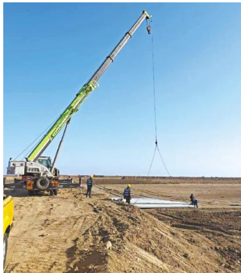
通威东营“渔光一体”生态园二期项目施工现场
